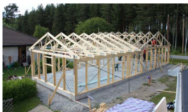
Takstolarna monteras.
